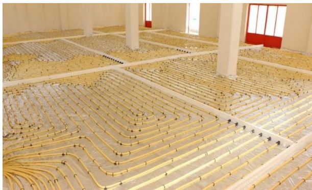
شکل ۲۸-۲ اجرای درز انبساطی برای مساحت بیش از ۴۰ مترمربع
