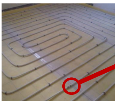
شکل ۱۹-۲ استفاده غلط از اتصالات در کف در سیستم گرمایش از کف
