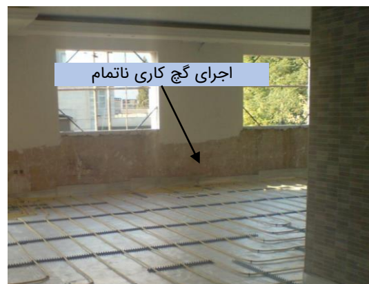
شکل ۵-۲ الف) اجرای غلط: گچ کاری ناتمام و انجام گرمایش از کف، ب) اتمام کاشی‌کاری تمام سطوح
