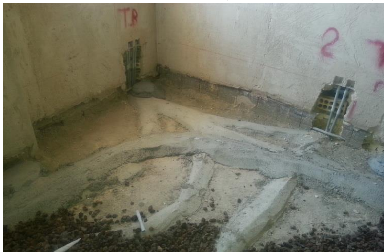
شکل ۱-۳۷ پوشاندن لوله‌ها پس از اتمام تست مجموعه برای جلوگیری از آسیب دیدگی
