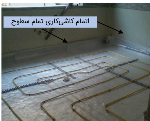
شکل ۵-۲ الف) اجرای غلط: گچ کاری ناتمام و انجام گرمایش از کف، ب) اتمام کاشی‌کاری تمام سطوح
