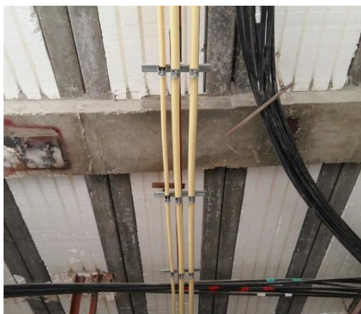
شکل ۲۳-۱ استفاده از بست مناسب برای نگهداری لوله
