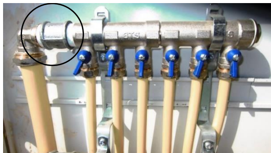
شکل ۲۹-۱ استفاده غلط اتصالات گالوانیزه در کنار اتصالات برنجی
