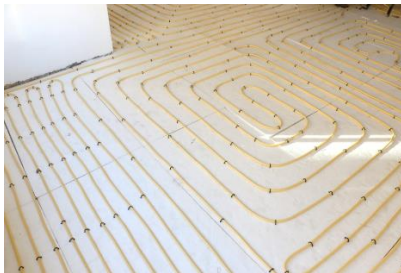
شکل ۲۵-۲ اجرای صحیح استفاده از بست خاردار
