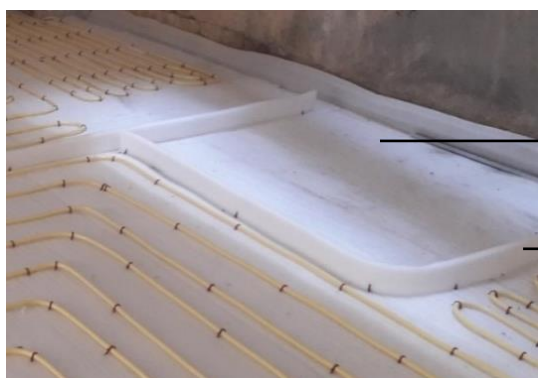
شکل ۱۶-۲ عایق نمودن محیط‌های بدون گرمایش برای جلوگیری از اتلاف حرارت و آسیب دیدن بتن و تجهیزات
