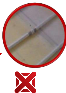
شکل ۱۹-۲ استفاده غلط از اتصالات در کف در سیستم گرمایش از کف
